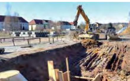
Vom 14. Januar bis Ende Juni 2019 fanden Baumaßnahmen auf dem Parkplatzgelände vor dem WEBALU statt. Diese wurden durch die Stadt Werdau durchgeführt und dienen im Rahmen der Hochwasserschadensbeseitigung der Instandsetzung der Verrohrung des Kranzbergbaches. Während der Bauphase stand der Parkplatz nur zur Hälfte für unsere Gäste zur Verfügung.
